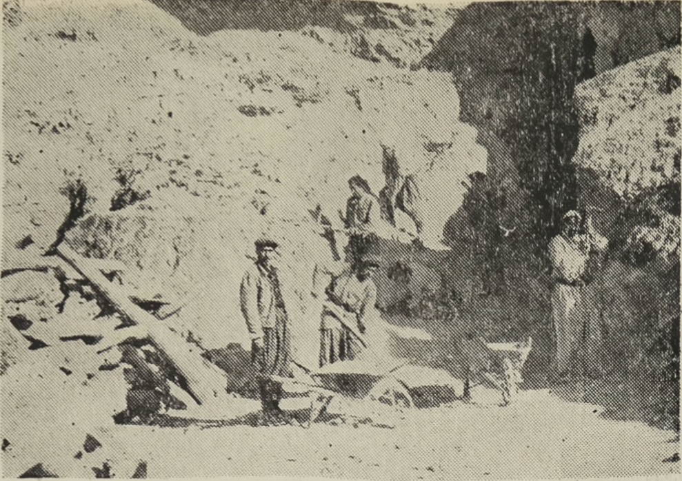
Gaziantep'te Belediye çalışmaları (Öğretmen evlerinde yol yapımında çalışan Belediye iş- çilerini görüyorsunuz.)
