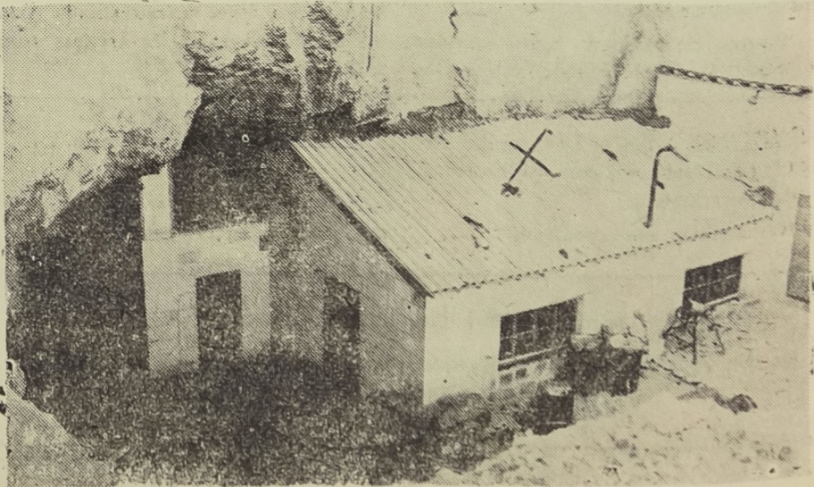
Belediye Su işletmelerine ait bir su deposunun dıştan görünüşü
