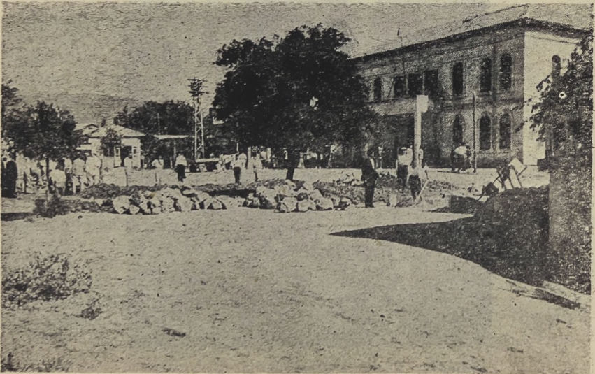
İslâhiye Hükümet konağı ve Cumhuriyet Meydanından bir görünüş
